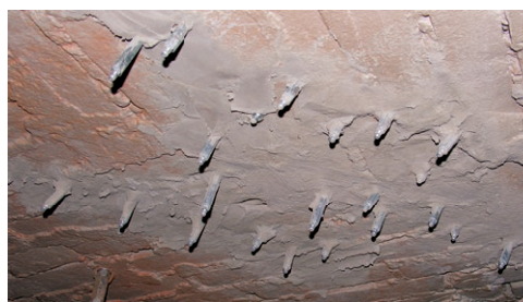
Gewölbedecke unter der Commerzbibliothek mit eingebrachten Injektionspackern
